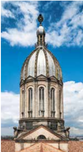
Cúpula exterior de concreto. Foto: Margarita Mejía-IDPC, 2014.
