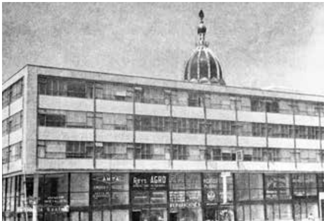
Edificio del Filosofado, 1960. Fuente: Comunidad, 1962, anexo.
