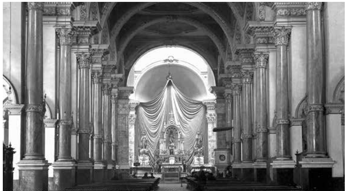
Nave del templo del Voto Nacional. Fuente: BLAA. Foto: Gumersindo Cuéllar, ca. 1938.
