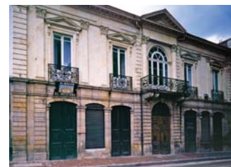
| FACHADA DE LA RESIDENCIA QUE HABITÓ NEMESIO CAMACHO, NOTABLE EJEMPLO DEL ORDENAMIENTO FORMAL QUE EXPERIMENTÓ LA IMAGEN PÚBLICA DE LA ARQUITECTURA DOMÉSTICA DE LA CIUDAD A INICIOS DEL SIGLO XX.
