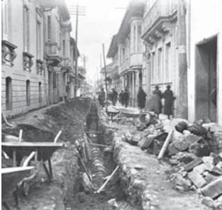
| TRABAJOS DE INSTALACIÓN DE LA NUEVA TUBERÍA DEL ACUEDUCTO, REALIZADOS HACIA 1928 EN LA CARRERA 6A ENTRE CALLES 8A Y 9A. FONDO LUIS ALBERTO ACUÑA, MUSEO DE BOGOTÁ.
