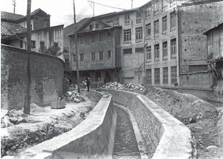
| FOTOGRAFÍA POSTERIOR A 1927, DONDE SE OBSERVA LA CONSTRUCCIÓN DEL COLECTOR DEL RÍO SAN FRANCISCO. FONDO LUIS ALBERTO ACUÑA, MUSEO DE BOGOTÁ.
