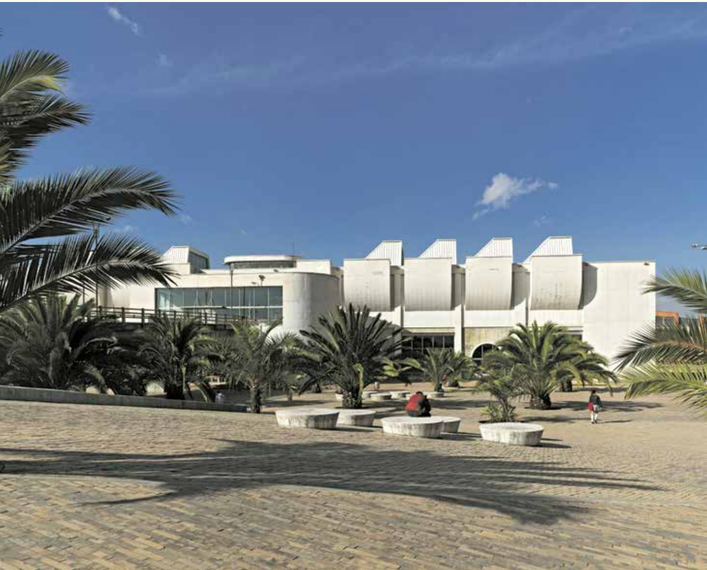
BIBLIOTECA EL TINTAL, DESPUÉS DE LA INTERVENCIÓN A LA PLANTA DE TRATAMIENTO DE BASURAS. ARCHIVO FOTOGRÁFICO DANIEL BERMÚDEZ
