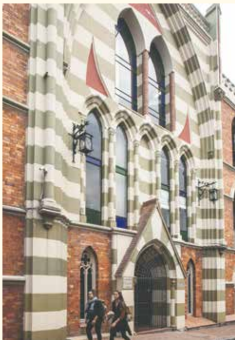
CONJUNTO DE APARTAMENTOS DE LA CALLE DEL SOL. FOTO: MARGARITA MEJÍA-IDPC
