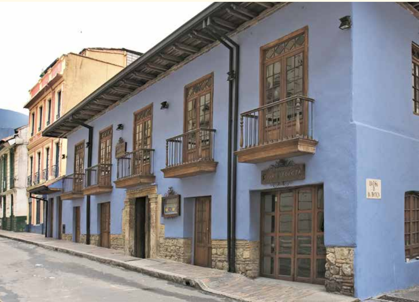
FACHADA Y CORTE TRANSVERSAL DEL PROYECTO CASA DE LA BOTICA. IMÁGENES: ARCHIVO HÉCTOR CALDERÓN BOZZI
