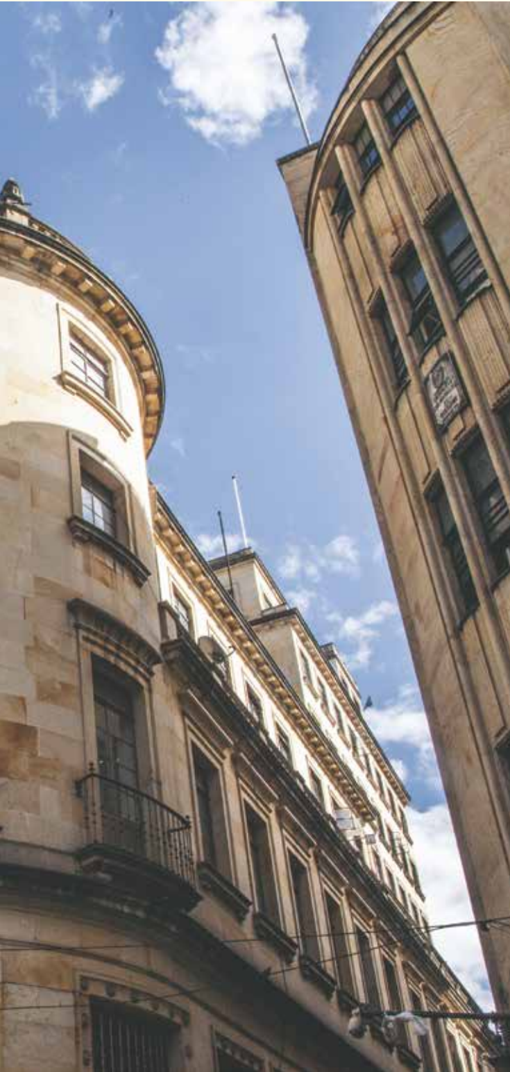
EDIFICIOS EN LA ANTIGUA ZONA BANCARIA DEL CENTRO HISTÓRICO DE BOGOTÁ FOTO: MARGARITA MEJÍA-IDPC
