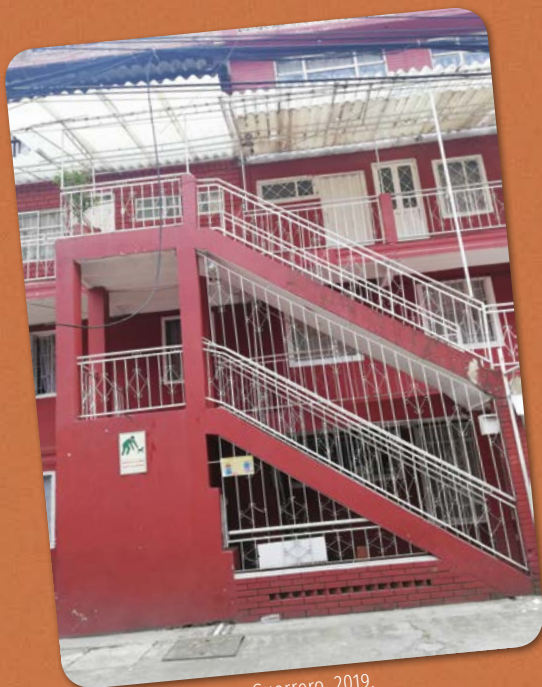
Escaleras. Foto: Valery Guerrero, 2019.
