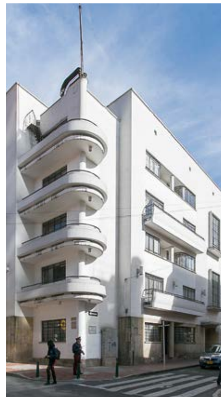
EDIFICIO VENGOECHEA / Foto: Carlos Lema - IDPC
