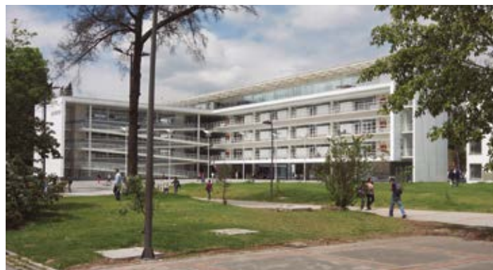
EDIFICIO DE CIENCIA Y TECNOLOGÍA / Foto: Carlos Lema - IDPC
